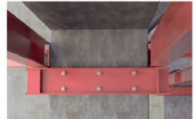
Vigas de acero
