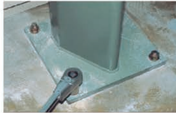
Estructuras de acero
