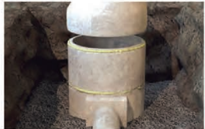
Sellado de anillos de pozos de concreto
