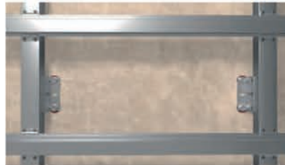
Subestructuras metálicas para fachada ventilada.
