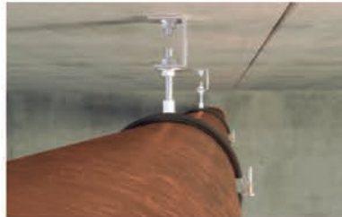
Instalación de tubería regulable en altura
