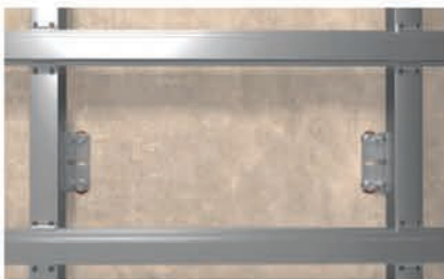
Subestructuras metálicas para fachada ventilada.
