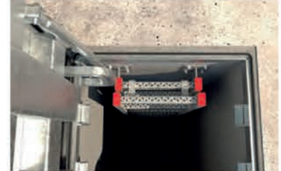
Bocas de registro del tanque de desbordamiento de aguas pluviales
