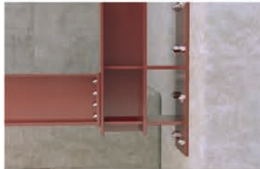
Vigas de acero
