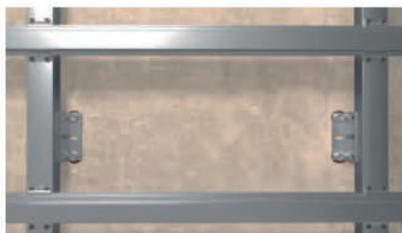
Subestructuras metálicas para fachada ventilada.
