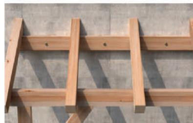
Subestructuras de madera para techos y cubiertas.
